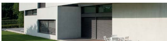
PORTONES ELÉCTRICOS EN COCHERA
